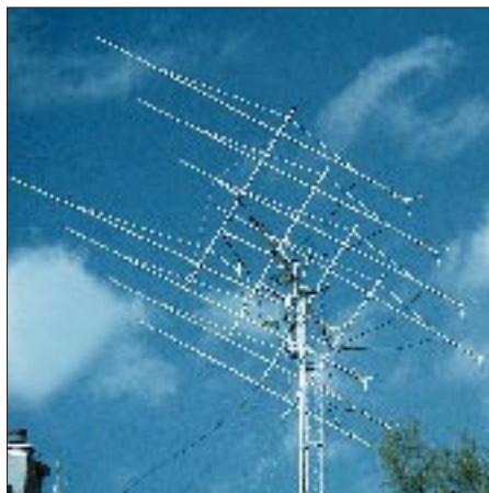
Die Antennenanlage von I5JUX besteht aus 8 x Shark Larets (4 WL) Foto: I4YNO
